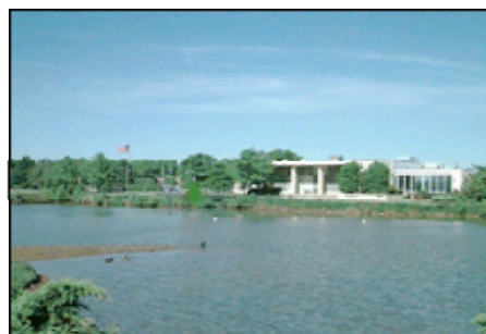
Mt. Laurel Data Center
